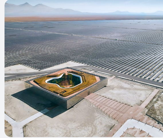
YEKA-1 405 MW GÜNEŞ ENERJİ SANTRALİ PROJESİ FAZ 1 / FAZ 2B
