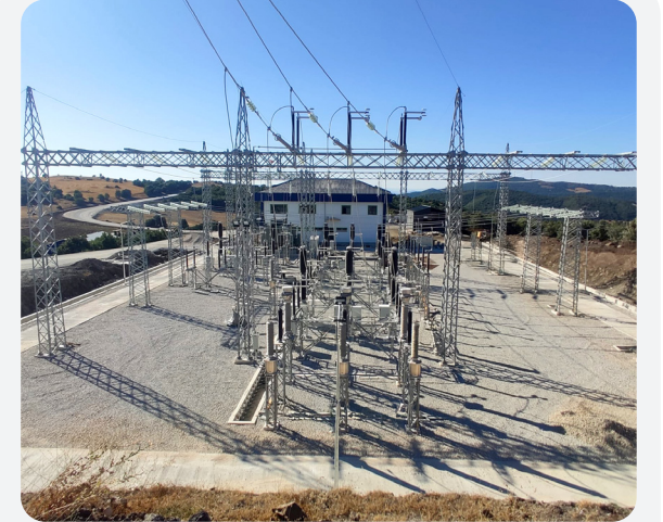
R3-YOZGAT-1 RES 154/34,5 KV TRAFO MERKEZİ PROJESİ
